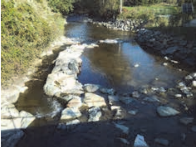
Negatives Beispiel: für die Leitfischart „Huchen“ deutlich unterdimensioniert und nicht ganz naturnah!
