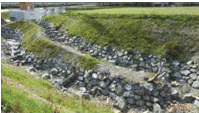
...noch im Bau
